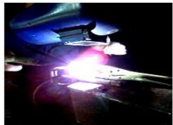
Figure 1. TIG (tungsten inert gas) Welding
