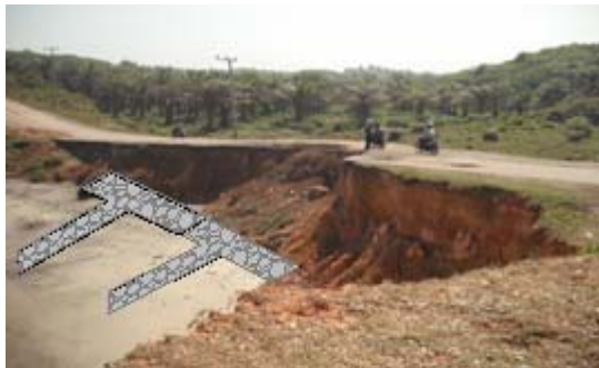
Gambar 5. Teknik Penanganan di Lokasi Urai II
